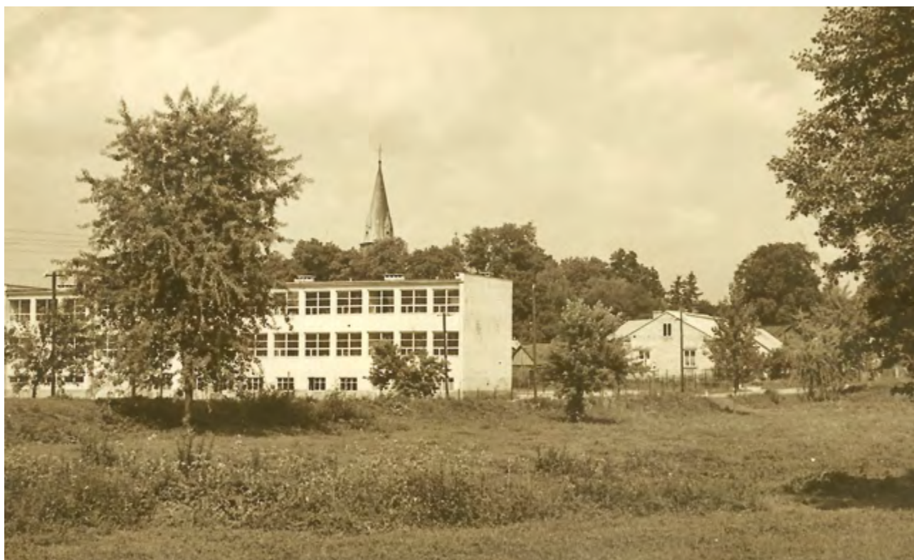
Budynek szkoły w Miastkowie Kościelnym, 1963 r. Fot. Archiwum Anny Mądrej
