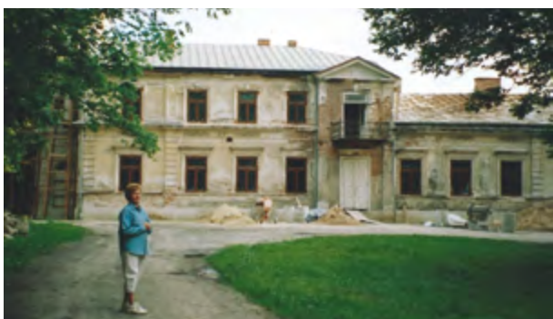
Elewacja frontowa podczas prac odbudowy pałacu, 2004 r.
