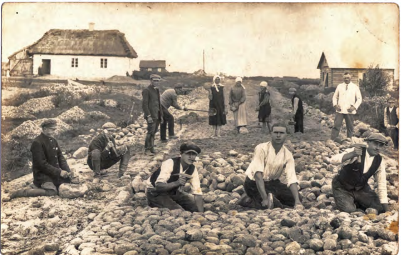
Budowa drogi relacji Miastków Kościelny – Żelechów. Obecnie ulica Warszawska w Miastkowie Kościelnym. Fot. Archiwum UG w Miastkowie Kościelnym
