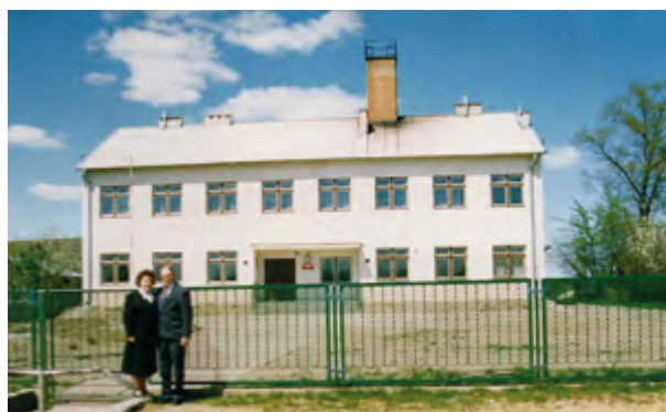
Budynek nowej szkoły, 1993 r.
