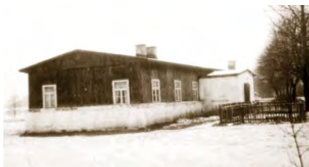
Szkoła w Zabruzdach.
