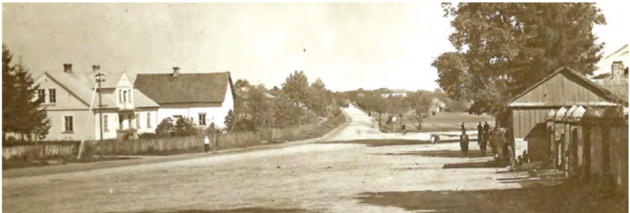
Centrum Miastkowa Kościelnego. W dali droga w kierunku Żelechowa. Fot. Archiwum Anny Mądrej
